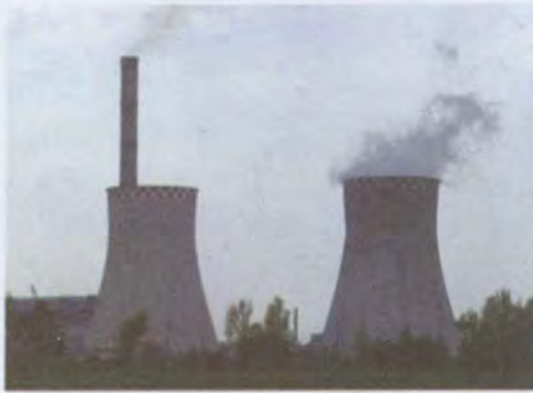
Рис. 92. Зуївська теплова електростанція, Донецька обл.
