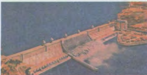
Рис. 93. Гідроенергетичний комплекс Санся (Три ущелини), Китай
